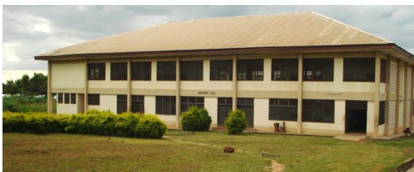
Schulgebäude in Akrofrom
