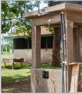
Das Bohrloch stellt mit 52,5 m Tiefe die erste Grundwasserquelle in dieser Tiefe im Dorf dar und liefert somit ganzjährig Wasser höchster Qualität. Zudem kann durch das Bohrloch weit
