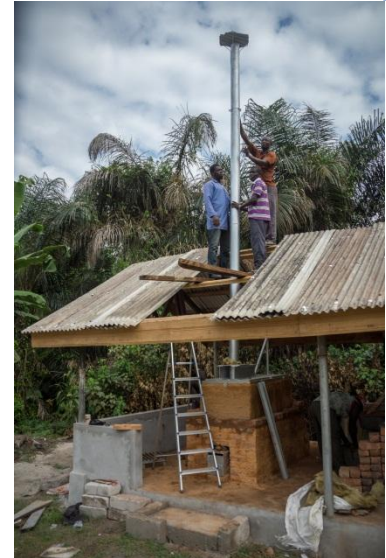
Schweißarbeiten für die Stahlteile des Ofens auf dem Stahlmarkt in Takoradi (links) und Aufstellen des Schornsteins am Waste Yard (rechts)
