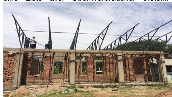
Grundgerüst der neu entstehenden Grundschule
