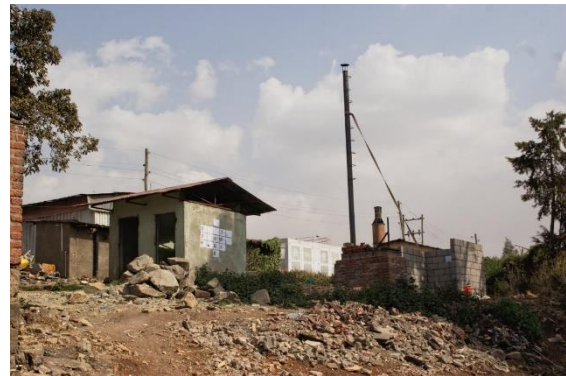
Ofen nach Abschluss der Bauphase
