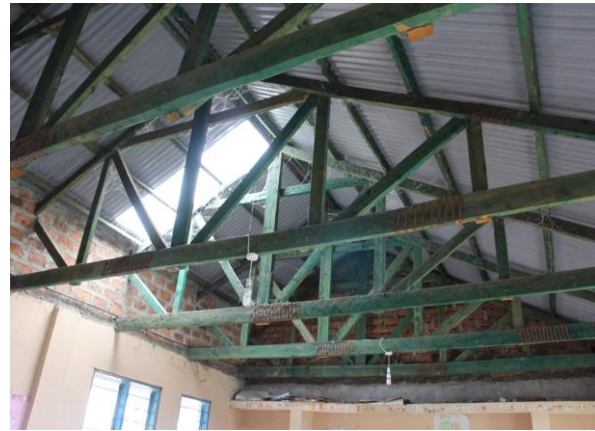
Dachkonstruktion des alten Schulgebäudes
