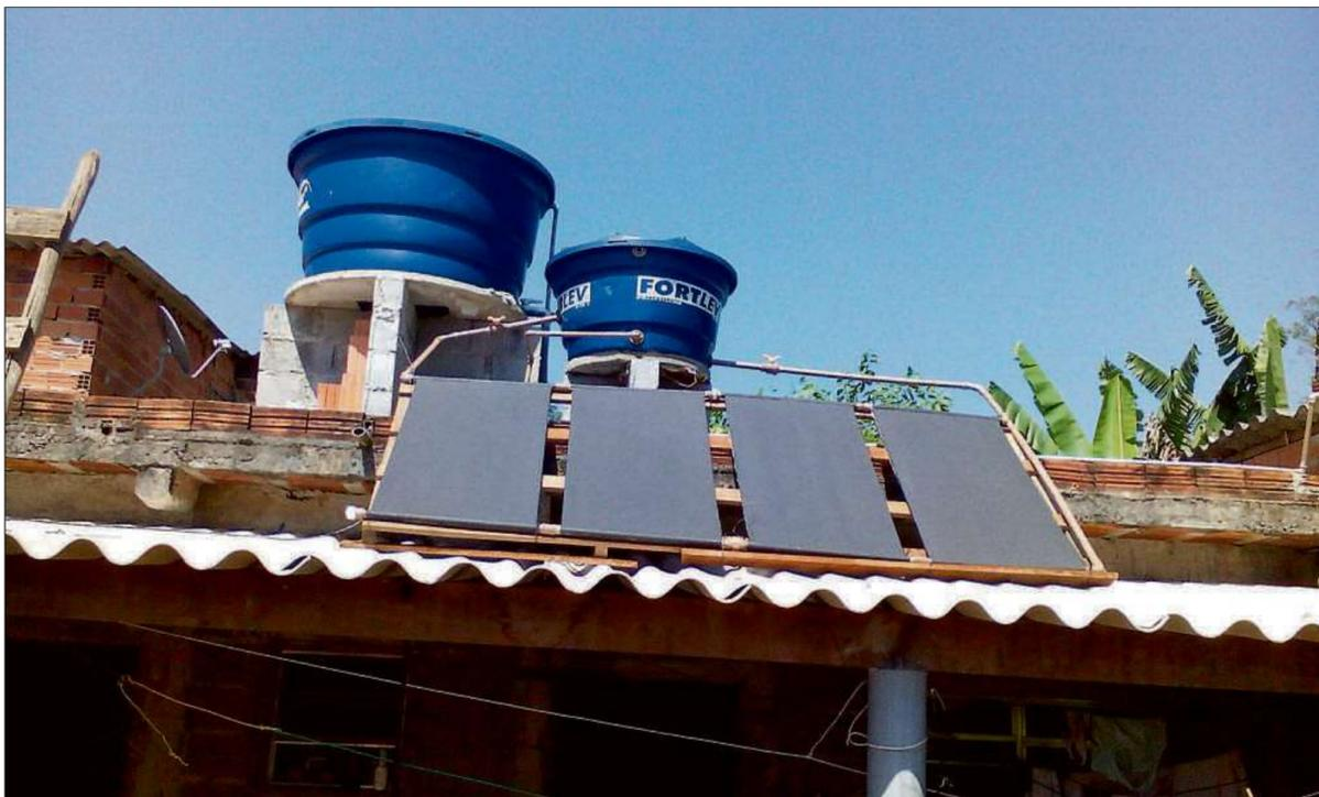
Zwei Kübel auf dem Dach dienen als Wasserspeicher, der größere für kaltes, der klein für warmes Wasser. In den schwarzen PVC-Hohlkammerprofilen wird das Wasser von der Sonne erhitzt, steigt, weil es nun leichter ist, wieder in den kleinen Kübel empor und wird von dort in die Dusche geleitet – alles ohne Strom. Bild: Michaelis
