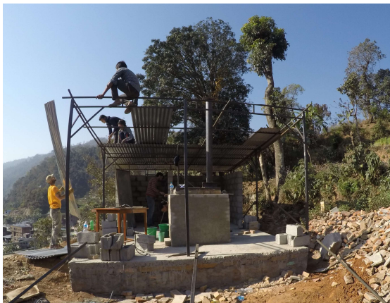
Arbeiten auf der Baustelle
