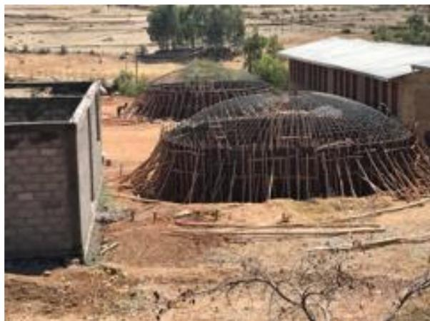
*Aufbau der Bewehrung für die Zisternen (links: Bodenplatte und Anfang der Wand, rechts: Wand und Kuppeldach)*
