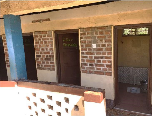
Toiletten (4 m + 4 w)
