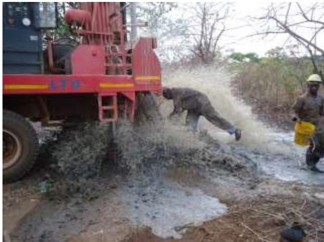
von 24m war eine Überraschung! Nach verschiedenen Pumpentests beträgt die gemessene Förderleistung etwa 1,5 m<sup>3</sup> pro Stunde. Die Wasseranalyse ergab ein positives Ergebnis und entsprach den einschlägigen tansanischen Normen.
